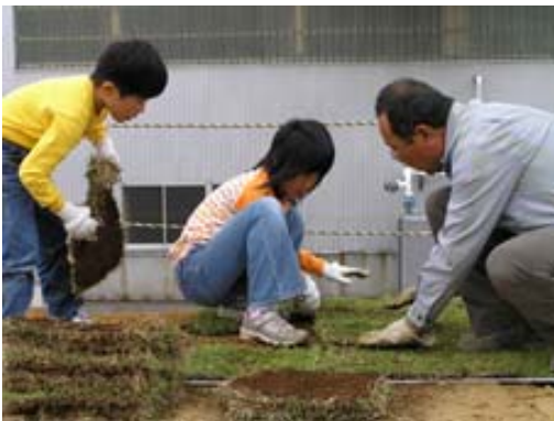
中ノ口川堤防の芝張り
